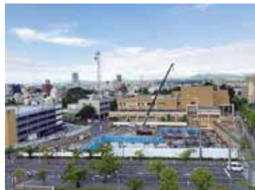
西側より施工状況を見る。南側（写真右）に盛土を行い、西・南面からのアプローチを可能とした
